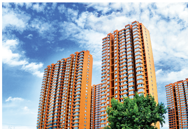
在厂庆80周年到来之际,22宿舍旧区改造工程将划上圆满句号,首批拆迁户于8月初即可拿到自己盼望已久的新房钥匙。图为22宿舍新区一景。 白治斌 摄
