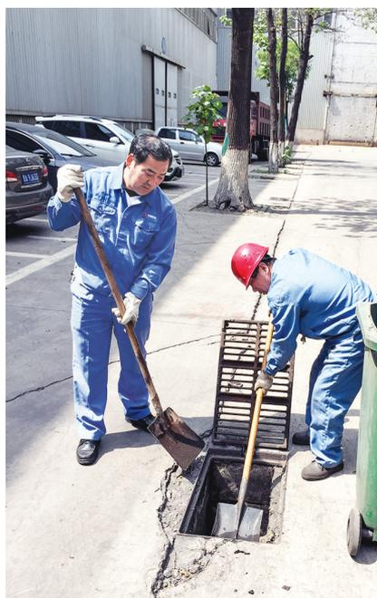
型材厂进一步做好防汛工作,对厂管辖区域下水通道进行定期排查,发现问题及时处理,确保管道畅通无阻。图为清理下水管道现场。 刘晋龙 摄
