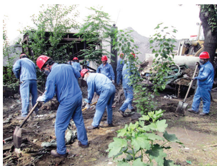
因为组织党员骨干清理抑尘网南侧现场杂物。
