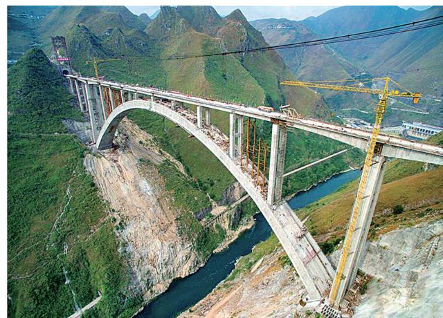
11月19日,位于贵州省安顺市境内的沪昆高铁北盘江特大桥顺利合龙。大桥全长721.25米,其中主桥445米的跨度,在目前世界同类型铁路拱桥中跨度最大。北盘江特大桥的合龙标志着沪昆高铁全线控制性工程的建设取得重大成果。
