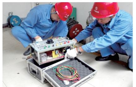
、管控难度大 的实际问题,通 过班组自主维 修、设备工艺改 进、技术团队研 发等形式进行全 面质量提升。图 为职工对高压试 验操作箱进行自 主维修
