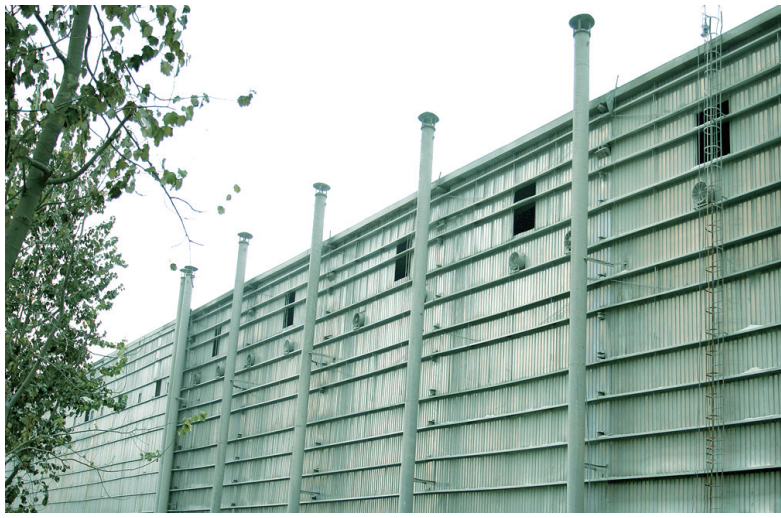
图为加工厂不锈钢渣冷却车间改造项目现场。
