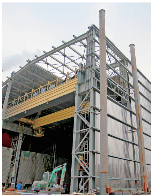
图为正在建设中的热焖处理线项目现场。 刘君 摄
