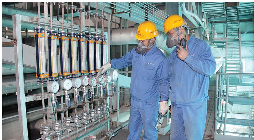
质量无小事,关键在用心。氮氧化物对环境的污染已经成为日益严重的全球性问题,它对大气的污染主要有酸雨和较高的地面臭氧浓度,也参与形成空气中的飘尘。为防止锅炉内燃煤燃烧后产生过多的NO<sub>x</sub>污染环境,袁家村铁矿从源头治理,控制燃烧中生成NO<sub>x</sub>,锅炉运行人员精细维护锅炉脱硝设备,确保脱硝效率达到最佳水平。图为运行工精细检查维护脱硝系统设备设施并进行适宜调整。 张文霞 摄
