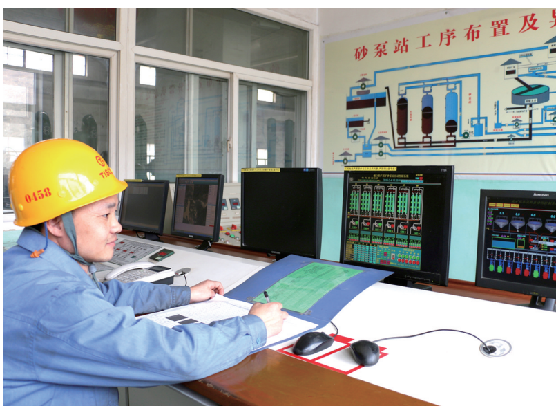
峨口铁矿通过加强安全生产运行管控、严格规范作业、强化逐级责任落实等一系列行之有效的措施,全面协调好安全生产、产品运输等各环节工作,确保了节日期间安全生产稳定运行。图为该矿砂泵工正在通过尾矿库在线监测系统相关数据观察尾矿库的安全稳定性。 王振华 摄
