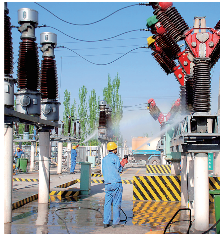
为保障电力系统安全稳定运行,复合材料厂未雨绸缪、积极筹划,于近日完成了一年一度的春检春试工作。图为变电站检修时,该厂机动部职工清洗站内设备积尘。 邱宝文 摄
