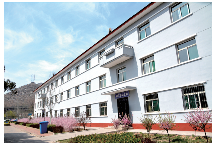
为切实改善单身职工生活条件,复合材料厂以经济适用的理念为指导,对老旧单身宿舍进行了公寓化改造,在每个房间内增设了卫生间。目前,符合入住要求的单身职工已经迁入新居。图为修缮一新的单身公寓外景。白旭峰 摄
