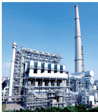
烧结烟气脱硫脱硝制酸系统
