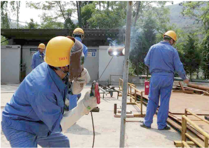
近日,东山矿积极开展技术比武活动,进一步提高职工岗位标准化操作技能和专业技术水平。图为制粉作业区焊工技术比武现场。 申热 摄
