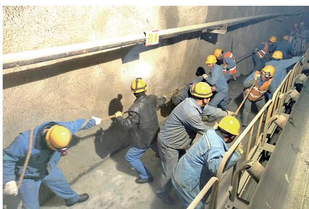
为满足工艺优化要求,峨口铁矿平峒作业区克服峒室空间有限、作业战线长、托辊架重量大等不利条件,自制运送备件小推车,组织员工齐心协力圆满完成了托辊架的更换任务,为一峒开工做好前期准备。王玉娥 摄
