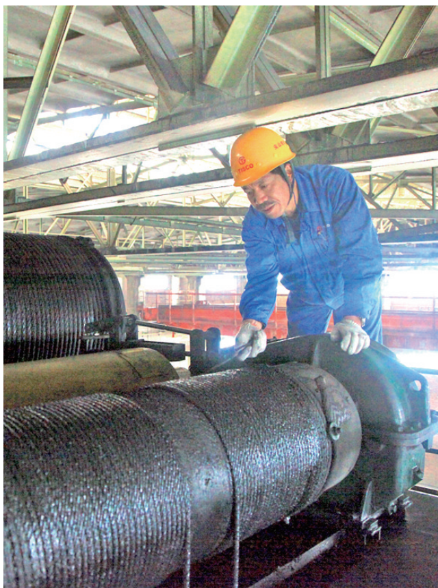
尖山铁矿认真贯彻落实公司“两会”精神,广大职工树立“创新先行,质量为本”的理念,充分发挥聪明才智,为企业发展尽责至善,尽心竭力。图为天车工正在检查改造后的钢丝绳使用情况。
