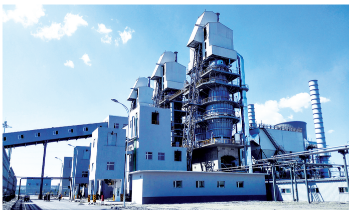
图为该项目建设现场。工程技术公司 提供
