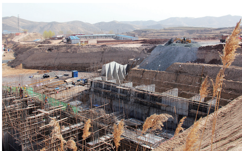
大钢袁家村铁矿强化责任担当,狠抓责任落实,持续提升效率,推进工程建设。自今年1月5日1号矿石1515m半移动破碎站移设工程动工以来,经过甲乙双方共同努力,目前该工程破碎站基坑、设备、挡墙土方开挖和设备基础浇筑已完成,破碎站挡墙浇筑正在进行,高度达到6m以上。预计6月30日破碎站土建施工全部完工,具备设备安装条件。图为施工现场。李林春摄
