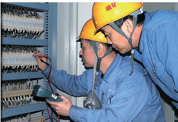
“仪器仪表的准确度是操作调控的依据,仪器仪表表热系统受高温影响,在传输过程中容易出现与实际不符的现象。”峨矿焙烧作业区电工班班长郎文明说。为此,电工班认真开展全系统仪器仪表排查,通过现场实际数据与电脑瞬时数据比对,消除误差,为集控有效操作提供可靠依据,确保工序稳定,产品质量稳定达标。图为电工正在排查。 赵冬梅 摄
