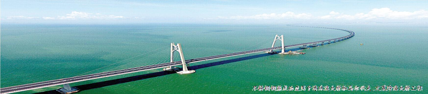
不锈钢钢筋成功应用于港珠澳大桥岛隧工程、文莱跨海大桥工程
