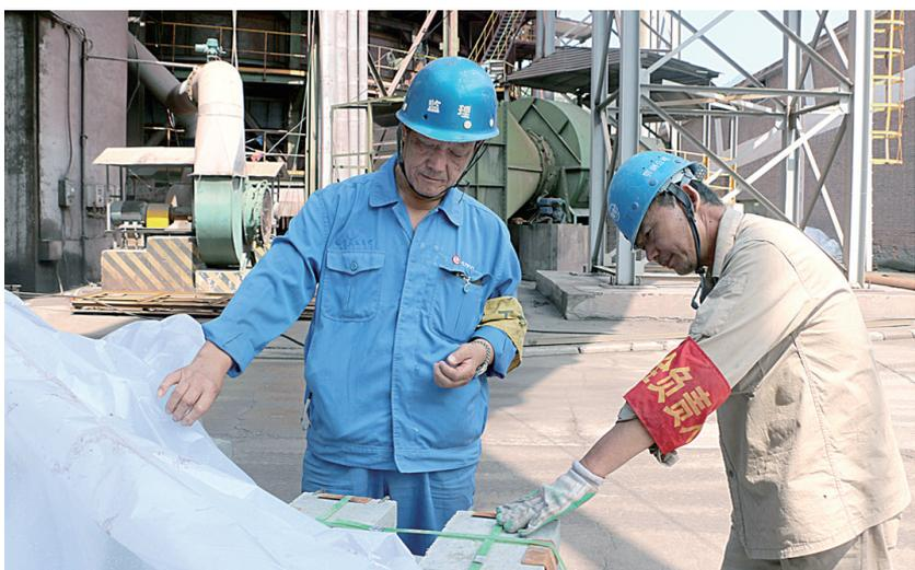
峨矿球团年检期间,现场随处可见监理检查、验收、指导的身影。他们以极其认真负责的态度,对检修工程进度、工序质量、安全以及隐蔽工程进行审查,确保检修安全、质量和进度。图为监理正在对受料斗使用的耐磨预制砖材质进行查验。 赵冬梅 摄
