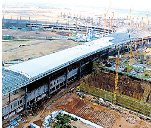
建设中的青岛胶东国际机场
