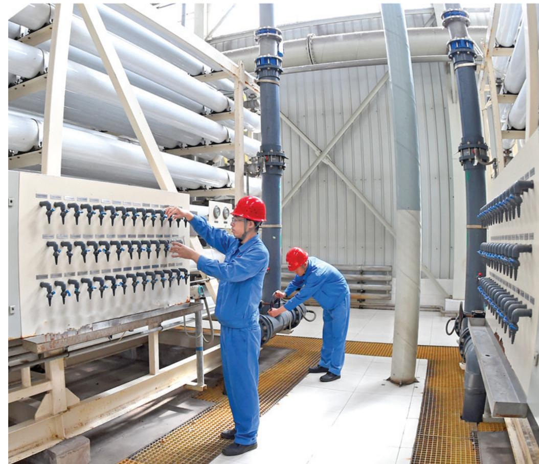
近年来,太钢采用先进工艺技术,工业污水处理及回用指标达到同行业领先水平,节约了大量水资源。图为职工在膜法水处理车间进行污水处理作业。
