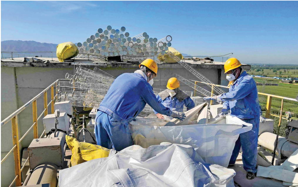
复合材料厂不断巩固深化“不忘初心、牢记使命”主题教育成果,把主题教育作为引深学用的重大契机,融入岗位、融入工作。图为复合作业区党支部主动请缨参加回转窑年度检修,积极组织更换成品除尘袋。
