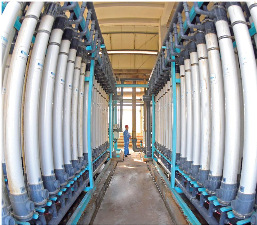
公司以科技创新和技术进步为支撑,创新研发钢铁废水双膜法技术,形成了“工业废水+城市生活污水”规模化综合利用模式,全面实现废水资源化,工业水重复利用率达到98%以上,在全国冶金行业名列前茅。图为污水处理作业一景。
