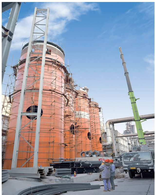
炼钢二厂坚持绿色发展理念,持续对不能满足超低排放要求的老旧式除尘系统进行升级改造,项目完成后,将极大提高现有除尘效率及除尘稳定性,同时有效避免清灰过程中的二次扬尘现象。图为该厂湿电除尘改造升级项目施工现场。 刘宝宝 摄
