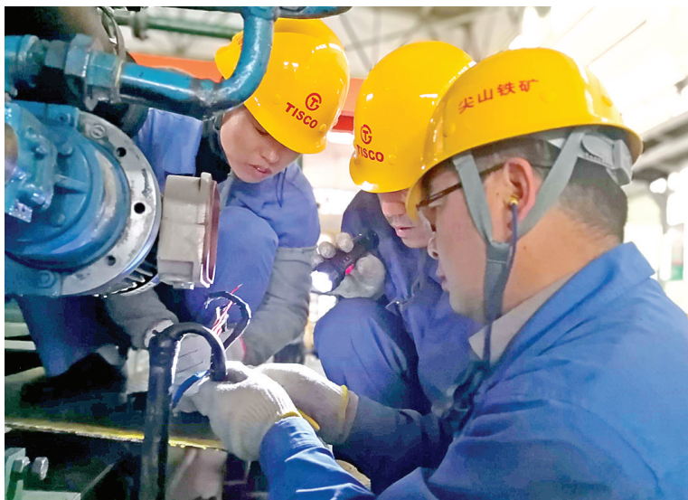
尖山铁矿强化设备日常管理,针对设备特点,从杜绝火灾、触电等方面,加强对设备的点检、维护频次,完善点检标准,实现设备安全平稳运行。图为职工对隔膜A泵减速机电机接线检查的场景。
