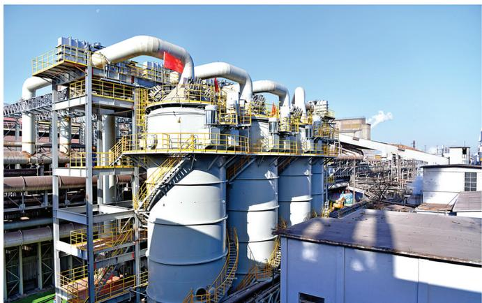
图为炼钢二厂转炉湿电除尘项目外景。
