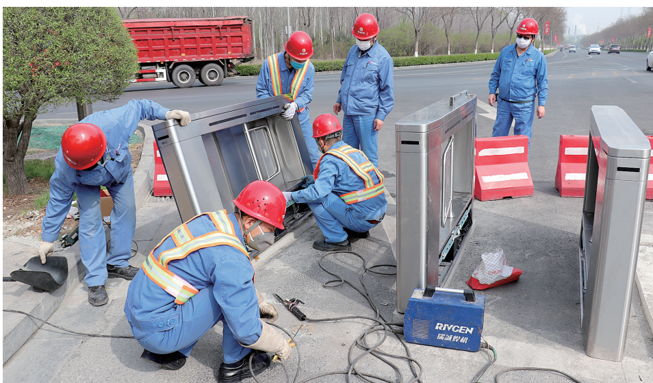
今年以来,信自公司克服疫情影响,提前筹备,制定计划,高标准高质量推进太钢供应链物流系统智能化升级改造。图为新南门智能门禁系统设备安装现场。
