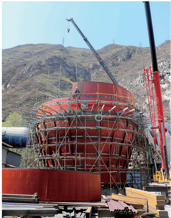
精准复工以来,太钢代县矿业公司球团超低排放工程设计、施工、属地各方紧密协作,严把质量进度关,全力以赴确保工程按计划完成并投入运行。图为吊装脱硝塔主体钢结构。
