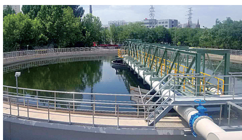
图为能动总厂污水沉淀池外景。 贺占超 摄
