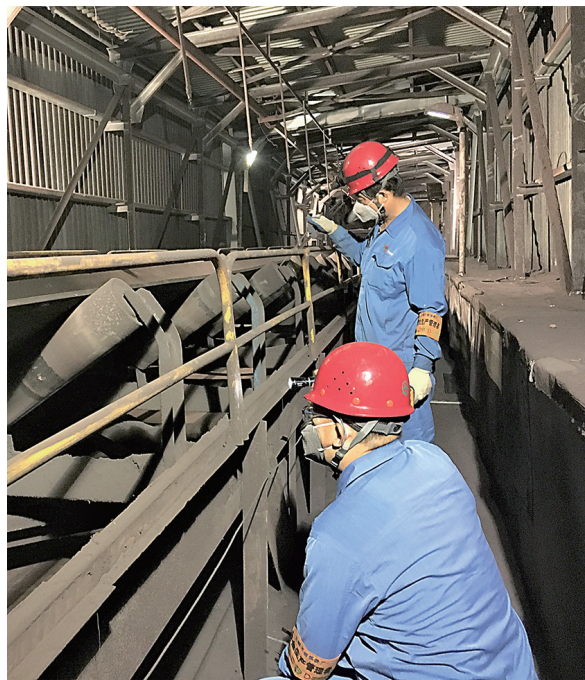
在公司系统检修中,炼铁厂供料作业区经过一个多月奋战,已率先检修完毕并具备运转条件,为生产做好了准备。图为岗位职工正在进行运转前的试车工作。
