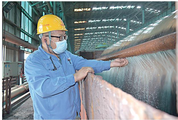
太钢岚县矿业公司严格落实“工艺与装备一体化”管理思路,不断提高工艺装备功能精度,近日集中对三系列弱磁机卸矿水系统进行了整改,对堵塞或锈蚀严重的卸矿水管进行更换,对个别出水不畅的卸矿水眼进行疏通,确保磁选系列工序运行稳定,保障了工艺指标合格。康莹 摄
