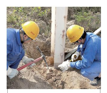
近日,东山矿结合自身实际,对全矿雨季生 产隐患进行拉网式排查,整改存在的问题,对采 场、管带机支架、排洪渠等重点部位组织专业人 员不定期勘察巡视,对区域内的排水渠进行疏通 清淤,真正使检查整改落到实处,见到效果。图 为管带机职工对沿线皮带支架基础进行检查并 修筑排洪沟。 孙宏伟 摄 高爱忠 文
