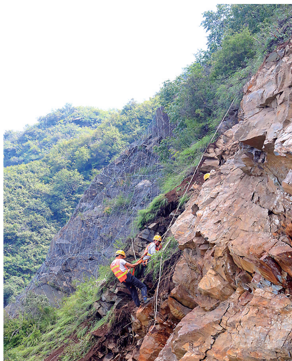
太钢代县矿业公司强化隐患排查整治,提前预防、科学决策,全力开展五道弯上山公路边坡危岩治理,为矿山安全稳定发展提供坚强保证。图为该矿对上山公路相关路段存在的边坡危岩进行系统处理。
