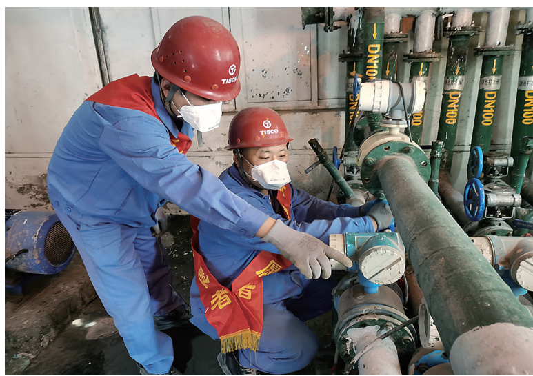
近日,加工厂碳素钢渣团支部邀请专业人员对钢渣打水精细化操作进行现场指导,提升青工质量意识,使青工能将设备、生产、工艺有机结合起来,持续提升钢渣质量。图为青工们正在进行打水量表精准操作。 张静摄
