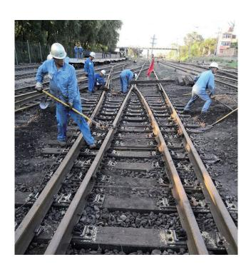
近日,物流中心工务作业区对编组站发运区域"咽喉"道 岔进行整治,通过改善道岔连接零件,加强道岔整体稳定性, 从而提升编组区域道岔的整体质量,满足编组站区域运量需 求,保障重点区域线路车辆通行安全顺畅。
