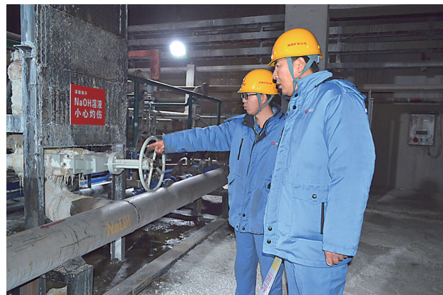
日前,太钢代县矿业公司对浮选作业区药剂制备间开展专项安全检查,重点对安全管理制度、作业标准、监测监控设施和装卸系统、药剂制备设备设施、输送管线和阀门、机泵等设备设施、紧急疏散出口、火灾报警系统、灭火救援设施等进行了认真排查,对检查过程中发现的问题要求立即整改,坚决遏制安全事故的发生,筑牢安全生产防线。康莹 摄
