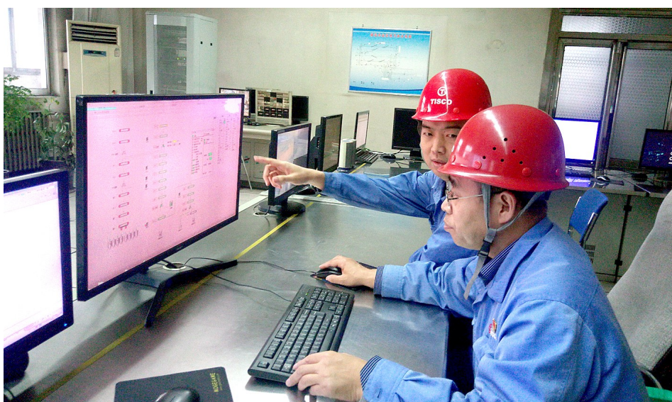
信自公司在太钢炼铁厂铁前物流智能升级改造中,克服改造规模大、范围广、工艺流程复杂、牵涉设备点多面广、自动化智能化控制功能实现难度较大等困难,优化技术方案,开展现场调试,目前正按节点顺利推进。图为调试现场。 李志宏 摄
