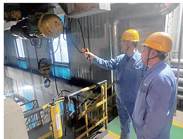
太钢岚县矿业公司原料作业区强化岗位交接班制度,管理人员现场跟踪,发现问题立即进行处理,有效避免了因现场交接班而影响正常生产。图为喷制煤区域交接班现场。 郝伟 摄
