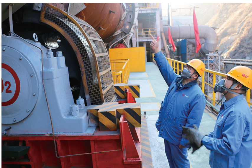
太钢代县矿业公司狠抓安全生产不松劲，做实风险分级管控与隐患排查治理，持续提高本质安全化水平，确保生产安全稳定运行。图为员工正在回转窑现场检查。
