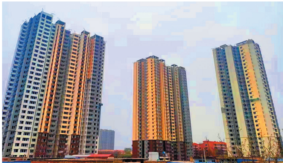
太钢迎新街红楼单身棚户区改造项目从 3 月中旬复工以来,全体参建人员在保证安全、质量、进度的前提下,按照年度目标积极推进,目前正在进行外墙涂料粉刷、户内管线、塑钢窗及消防设施的安装,配套工程也在有序进行当中。 王新龙 摄 张杰 文
