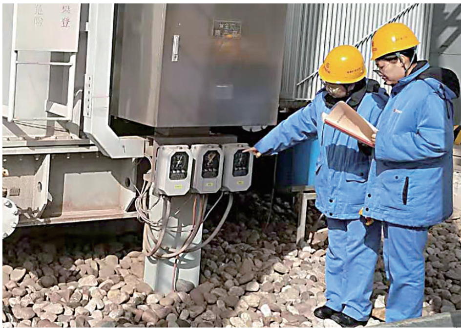
为了确保供电设备稳定运行，保障生产生活用电安全，太钢岚县矿业公司水电作业区组织人员加强设备现场巡视，对变压器、进出线瓷瓶、电缆隧道等重点部位进行重点关注，对后台负荷、电压、温度、SF6压力等数据严格把稳定、安全。图为变电站运维人员在点检变压器温度。 赵晶晶 摄
