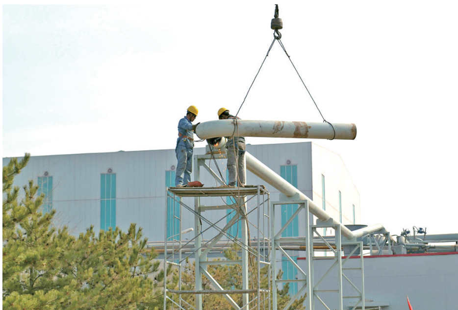
为进一步提高浮选工艺指标稳定性,太钢岚县矿业公司组织对绿色升级系统管道进行改造,确保综合精矿二氧化硅含量稳定率达标合格。图为施工现场。康莹摄
