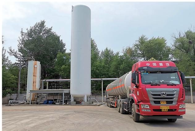
在前期工业试验成功的基础上,太钢成功实现二氧化碳替代氩气用于复吹转炉底吹冶炼,彰显了积极践行科技创新、节能减排、走可持续发展道路的理念。图为二氧化碳储罐车正在进行打压作业。
