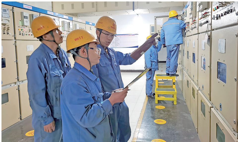
一直以来,标准化操作是太钢尖山铁矿确保职工人身安全的有效措施。该矿牢固树立安全发展理念,强化职工标准化操作,确保安全生产稳定,以优异成绩迎接建党 100 周年。图为职工对 3 号高压室高压设备进行标准化停送电作业。 杨辉摄
