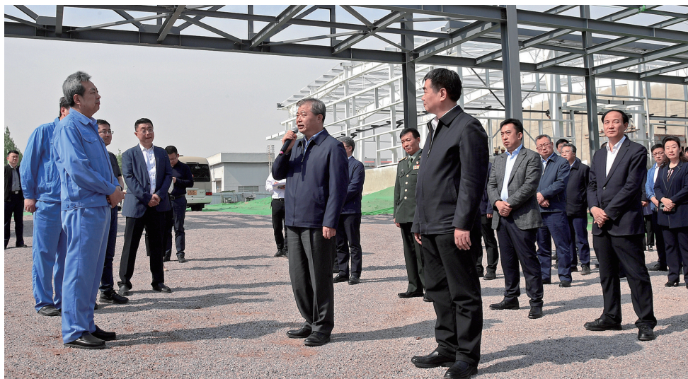
图为督导组在太钢碳纤维三期工程现场。
