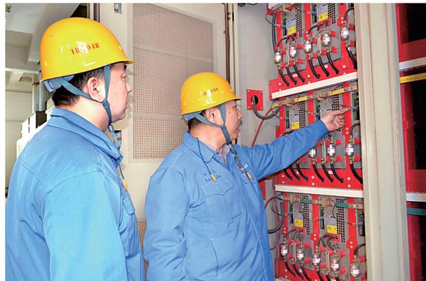
今年以来,太钢岚县矿业公司铆足“牛劲”,精准发力,规范电气设备管理及维护,全力打响电气设备安全保卫战,通过深入开展设备隐患自查自纠,建立完善设备隐患台账,确保电气设备安全高效运行。图为专业人员正在检查磨磁作业区高压变频器。康莹摄
