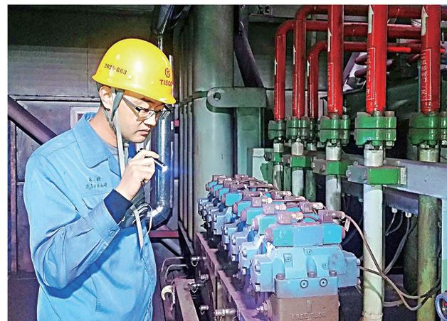
太钢岚县矿业公司球团部以设备“零故障运行”为突破口,从基础管理入手,建立系统化检修制度,采取设备劣化分析手段,科学精准制定设备检修计划,强化检修过程监督,为生产稳定运行提供可靠设备保障。图为设备管理人员正对火车装车润滑系统进行专业点检。
