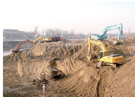
2004年12月10日，热连轧厂2250mm生产线土方开挖
