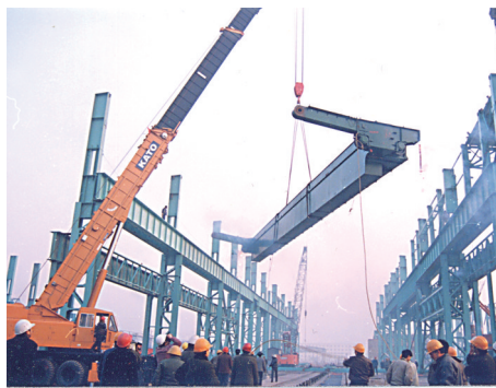
热连轧厂1549mm生产线厂房钢结构施工
