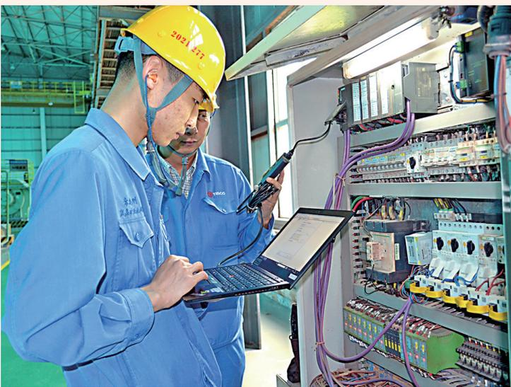
太钢岚县矿业公司以安全、高效、智能技术为着力点,全面提升“四个一律”水平,实现对设备运转数据的处理、分析和利用,完成对设备的智能管理和控制,为矿山智能化发展添动增能。图为技术人员正在优化环水系统隔膜泵通讯网络。
